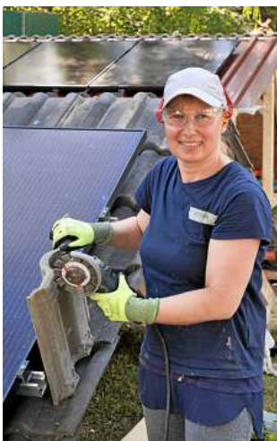
Annika Kiehne mit einem Winkelschleifer, um Aussparungen in Dachziegel zu schneiden.
